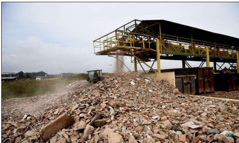
Figura 59 – Operação de beneficiamento dos Resíduos da Construção Civil, zona de triagem. (2021).
