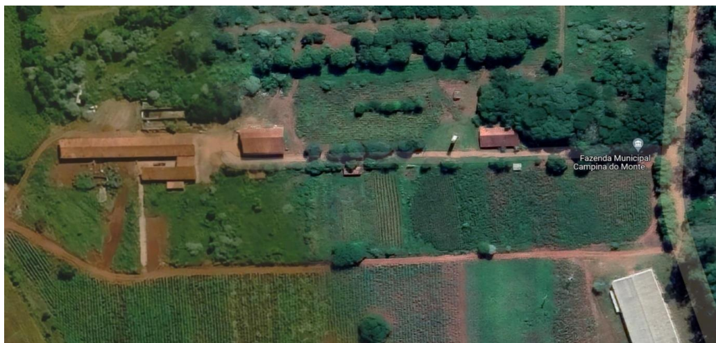
Figura 42 - Vista aérea da Fazenda Municipal, com área possibilitando instalações futuras de Central de Triagem de Resíduos Sólidos do município.
