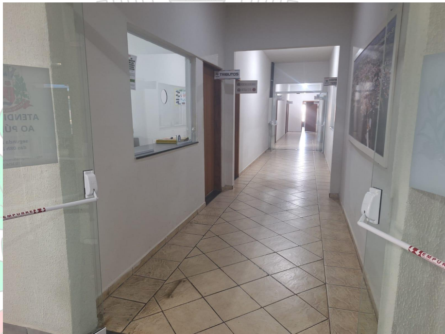
Foto 01: Corredores largos e portas acessíveis
